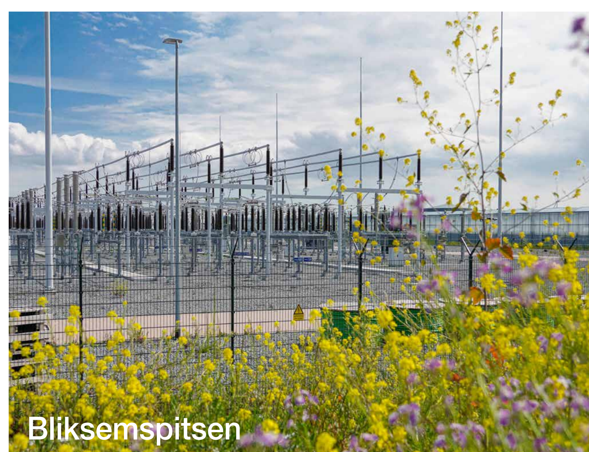
Hekwerk rondom het terrein
