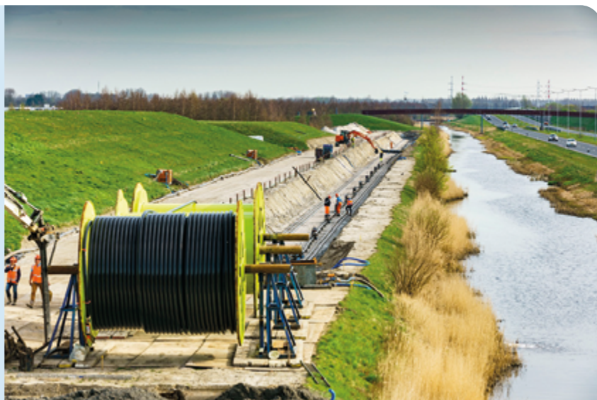
Ter illustratie het leggen van kabels in open ontgraving bij een ander project.
