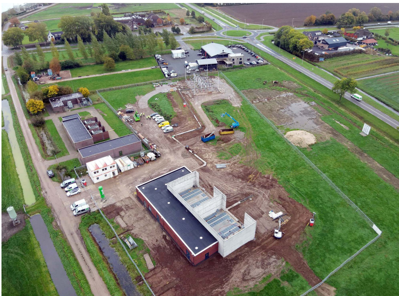
Luchtfoto elektriciteitsstation Zuilichem
