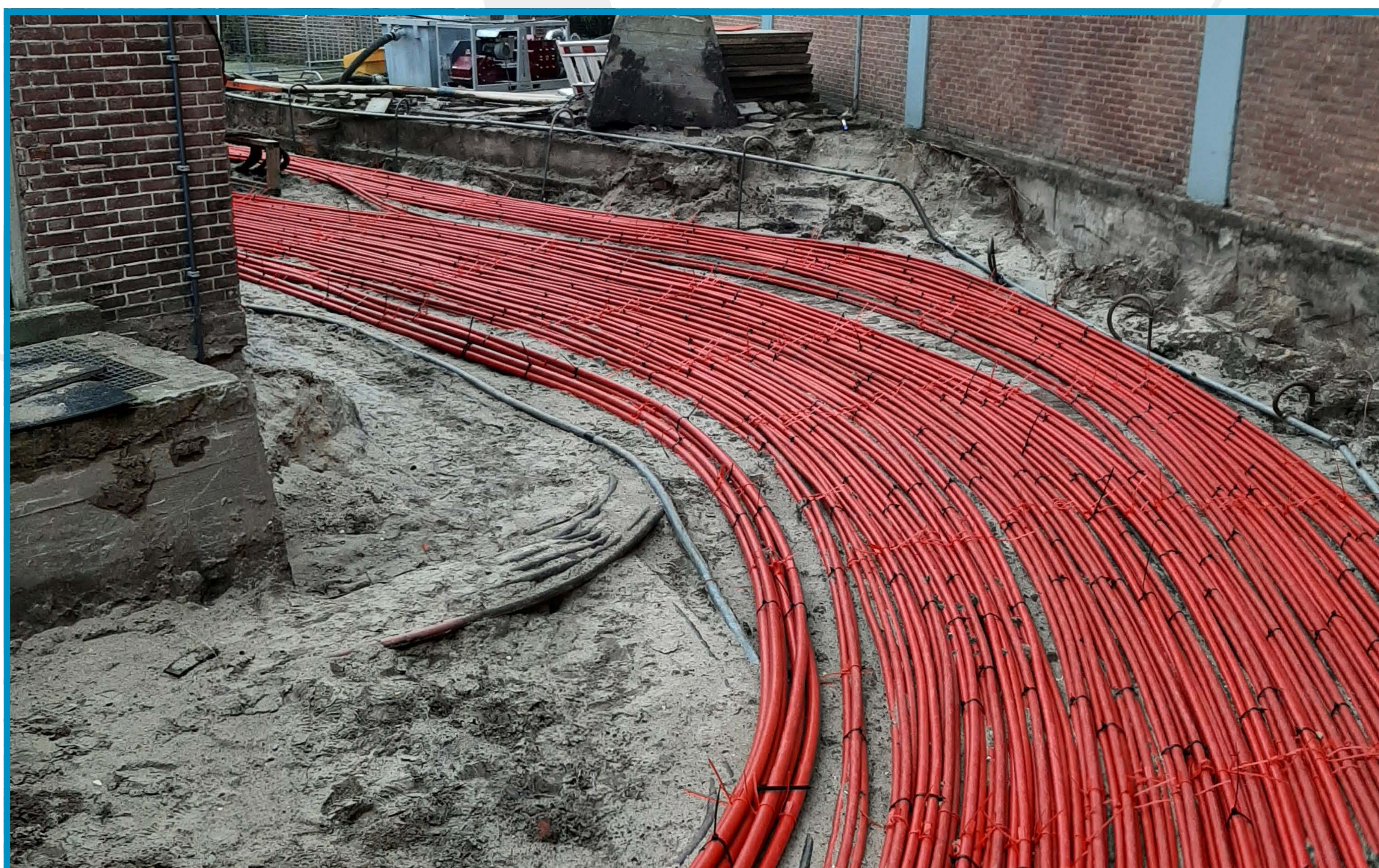
Ondergrondse kabelverbindingen.
