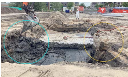
In de cirkel links zijn as en slakken te zien. In de cirkel rechts een oude fundatie.
