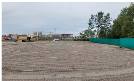
Het terrein is ingezaaid met graszaad.
