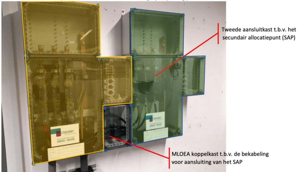
FIG-00083 - Standaard opbouw MLOEA AC4 klantaansluiting bij toepassing parallele aansluitmethode
