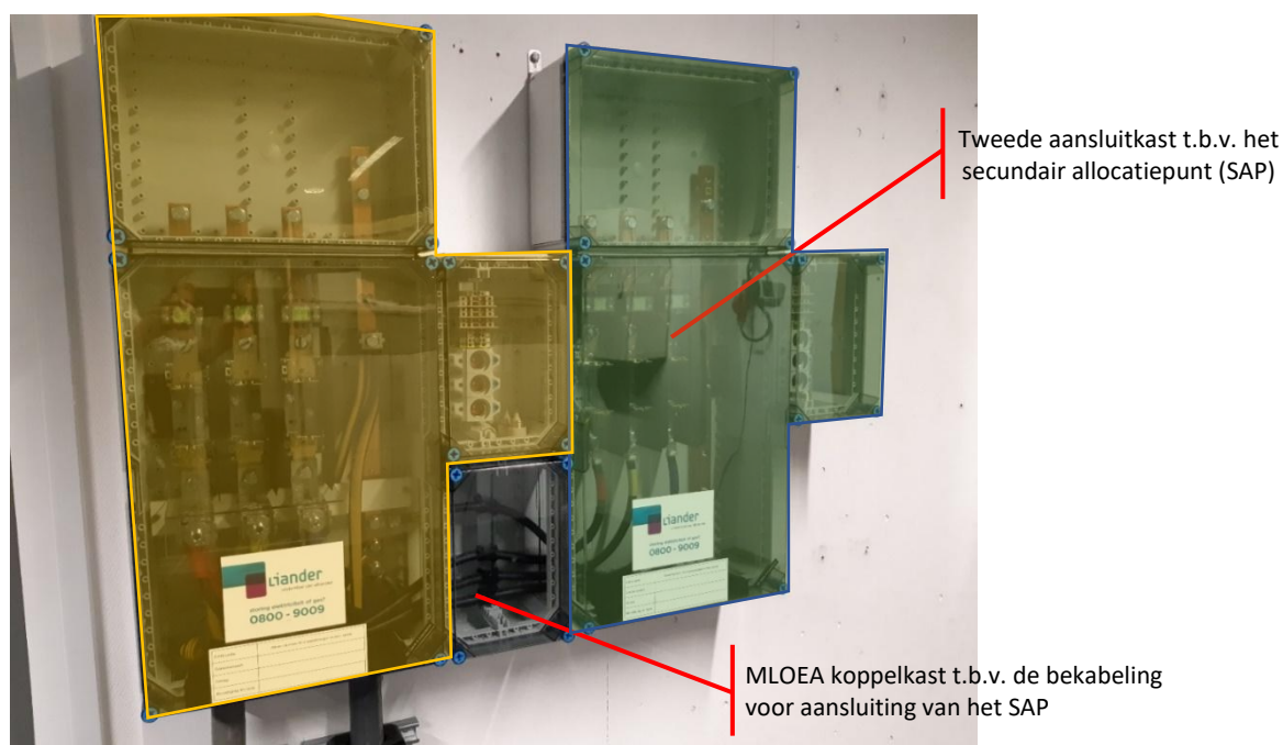
Figuur 7 Standaard opbouw MLOEA AC4 klantaansluiting bij toepassing parallelle aansluitmethode
